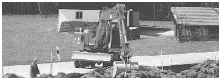
Die Erschließungsarbeiten am Oberdieberg sind in vollem Gange Foto: Zech
