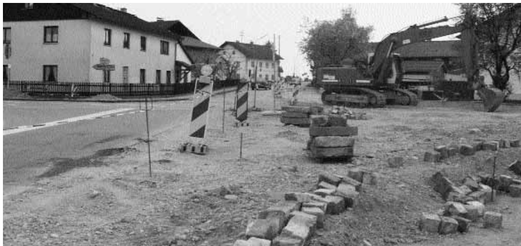
Halb Kreuzung halb Kreisverkehr - so zeigt sich die Baustelle im Albachinger Süden Text / Foto: gg
