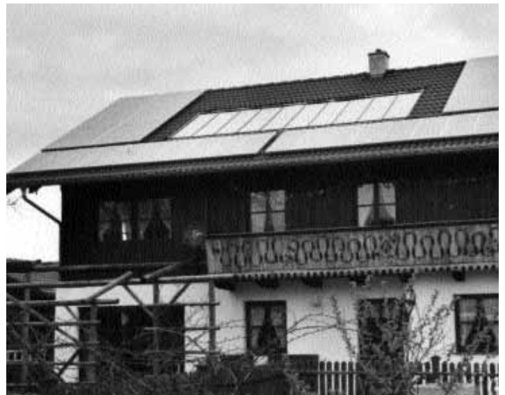
Die bereits fertiggestellte Anlage mit einer Leistung von 5,3 kWp. Foto: Neuwieser
