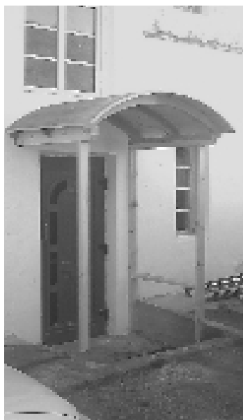
Vordächer, Gauben und Erker - darauf hat sich die Zimmerei Karl spezialisiert Foto: Karl
