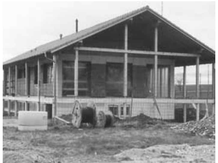
Nun geht es an den Innenausbau - der Rohbau des Vereinsheimes vom FC Maitenbeth.
