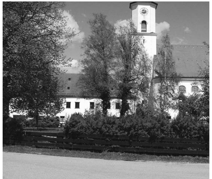
Hier sollen Schrägparkplätze entstehen (siehe auch „Kurz notiert“). Foto: Konrad
