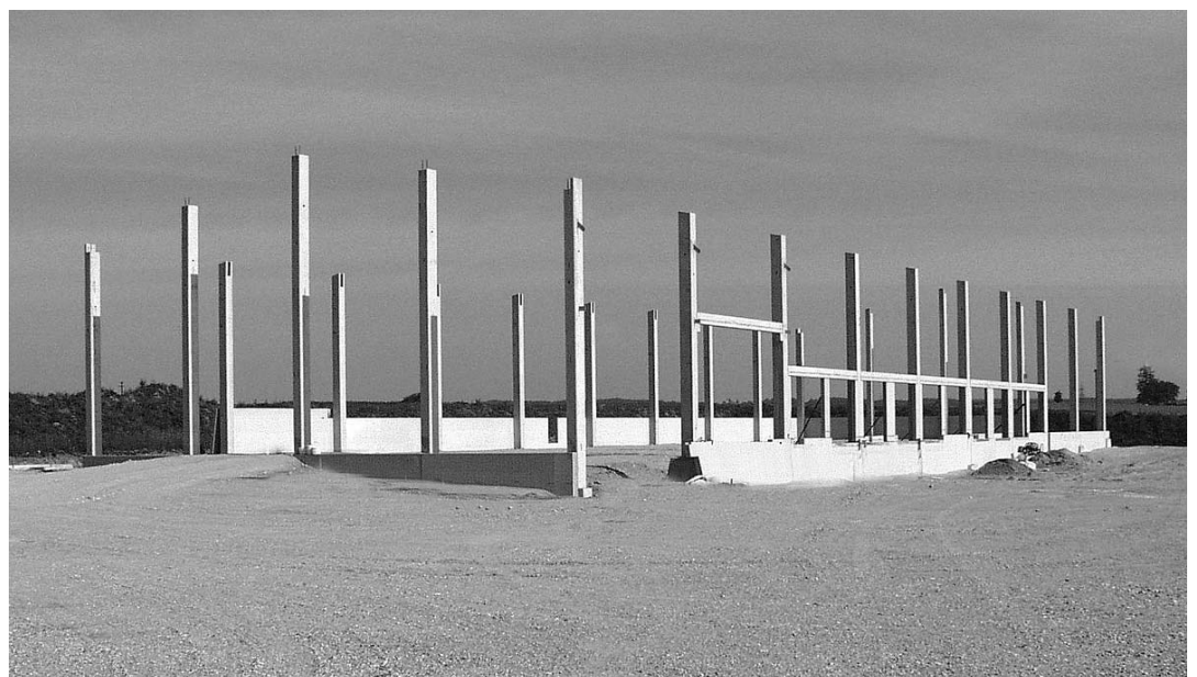
Die Fundamente für die Säulen der Akropolis wurden in Rekordzeit erstellt.
