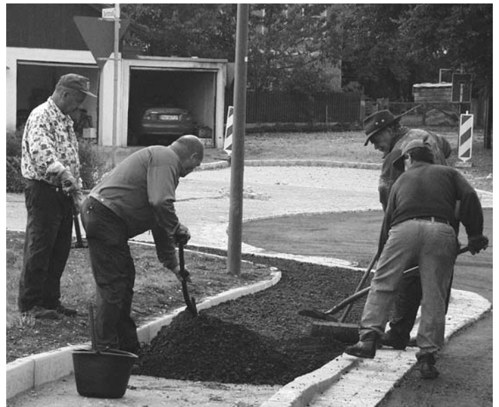
Asphaltierungsarbeiten am Gehweg neben dem Kreisverkehr Fotos: Konrad
