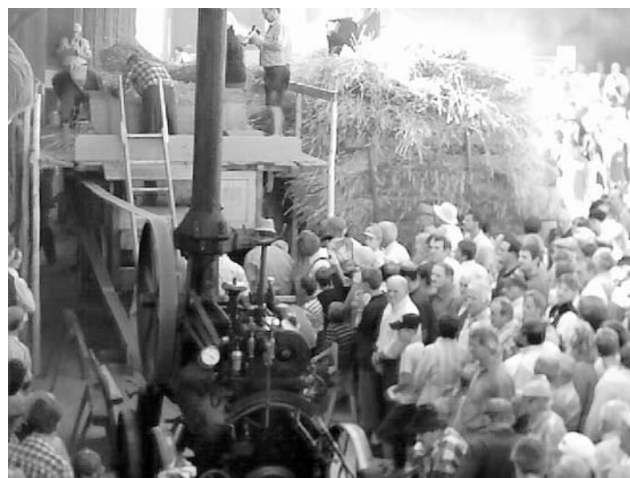
Die Dampfmaschine im Vordergrund trieb über einen Keilriemen den „Dreschwagen“ an. Foto: Manzinger
