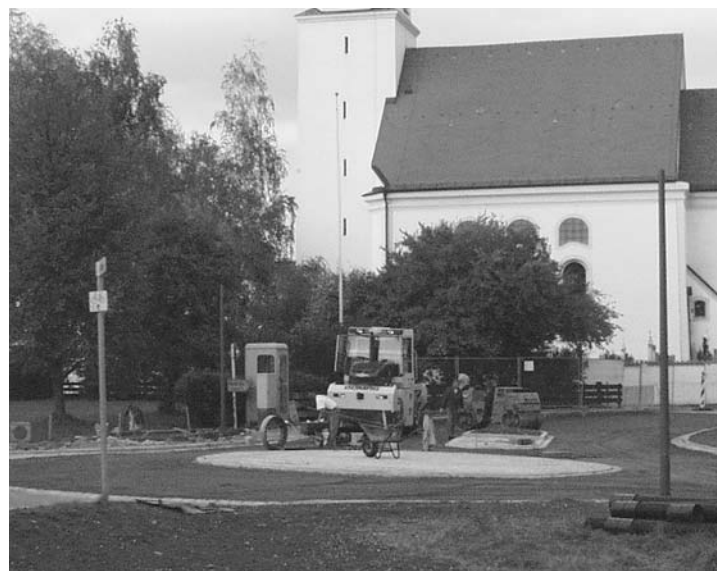
Der neue Kreisverkehrsplatz kurz vor der Fertigstellung
