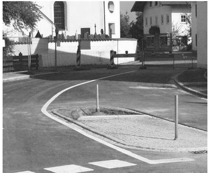
Diese Insel wurde nach einem Test mit einem Lastwagen noch etwas abgeflacht
