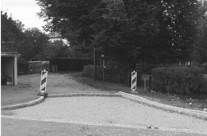
Diese Insel wurde nach einem Test mit einem Lastwagen noch etwas abgeflacht
