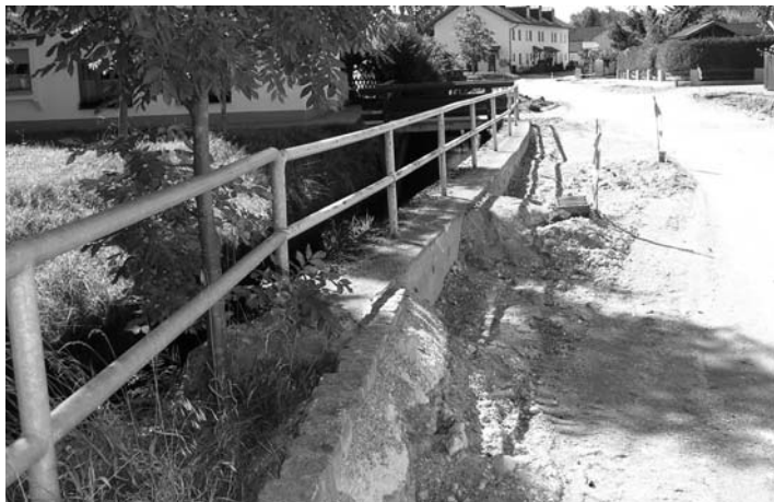
So sieht das bestehende Geländer am Nasenbach in der Ortsmitte aus. Laut Beschluss der Teilnehmergeinschaft der Dorferneuerung...
