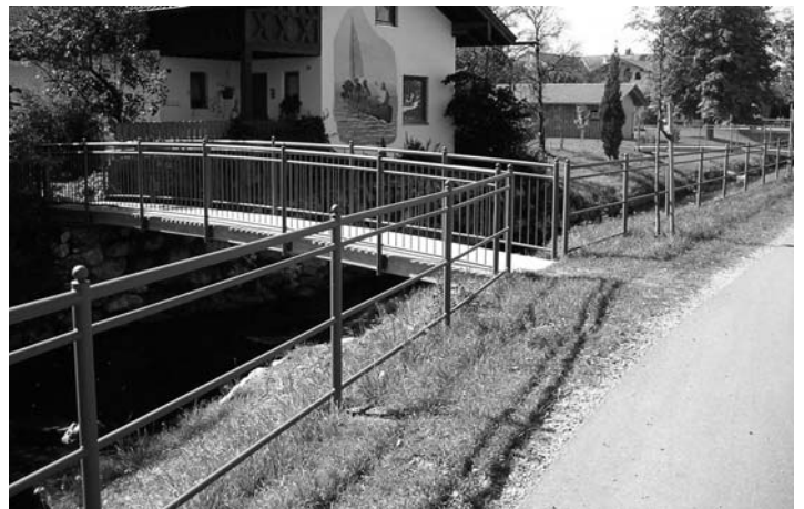
...soll das neue Geländer so ähnlich aussehen wie das Geländer am Bachlauf in der Gemeinde Söchtenau.
