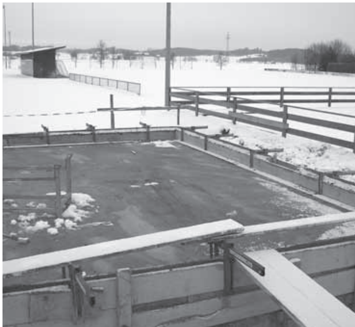
Die Baustelle am Sportgelände liegt westlich neben der Stockbahn...
