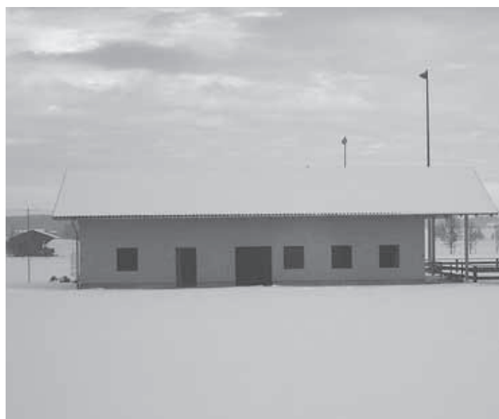
Der Rohbau zum Jahreswechsel: Bis auf Fenster und Türen ist alles fertig. Fotos: Konrad
