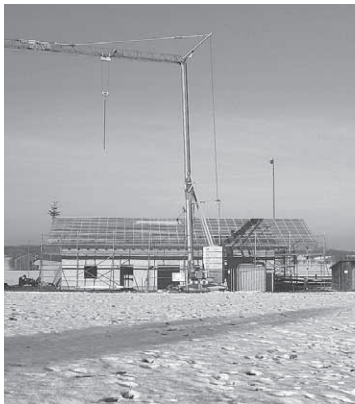
Die Dachkonstruktion mit Dachdeckung wurde im Dezember erstellt
