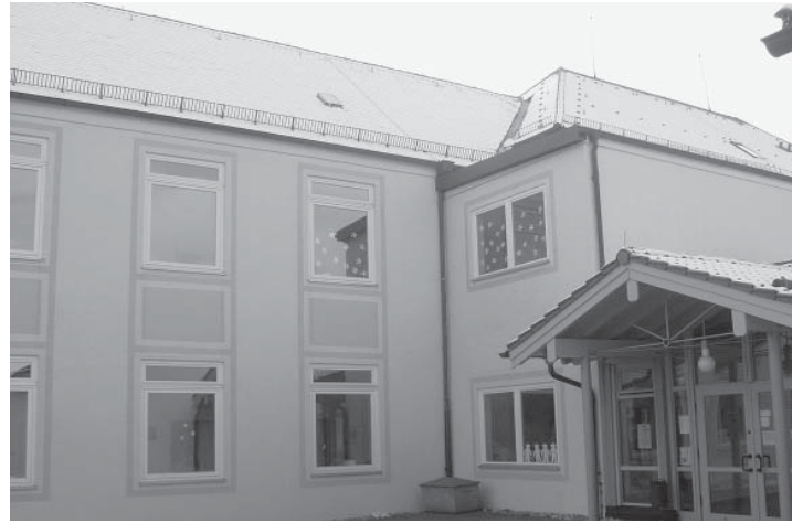
Die energetische Sanierung des Schulhauses wird den Gemeinderat noch länger beschäftigen. Foto: Konrad
