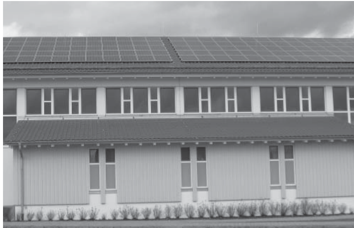
Die Anlage unmittelbar nach der Fertigstellung.
