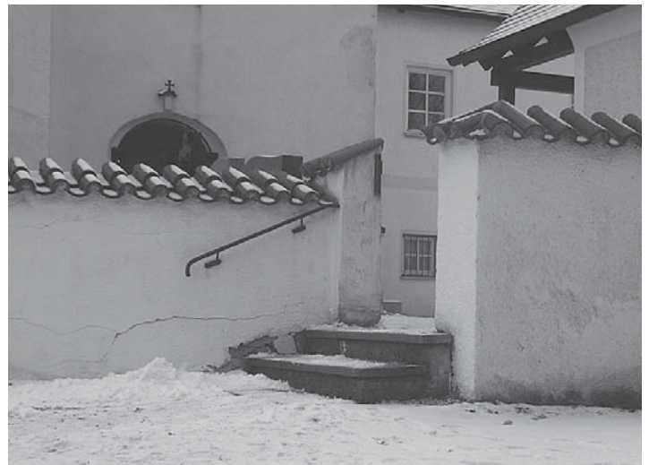
Eine Rampe soll bald die Stufen ersetzen: Der Friedhofszugang auf der Nordseite. Foto: Konrad
