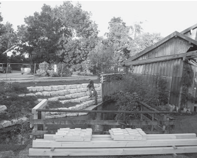
Die Absicherung der Bachaufweitung ist im vollen Gange. Foto: Franz Konrad
