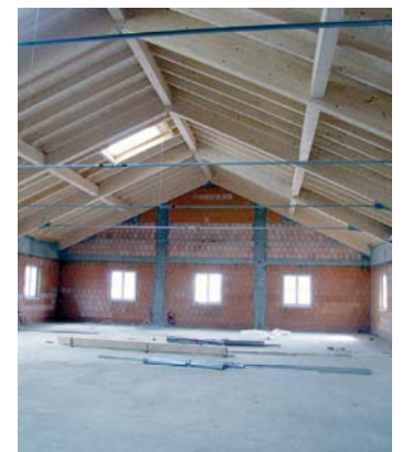
Der neue Albachinger Bürgersaal während der Bauphase.
