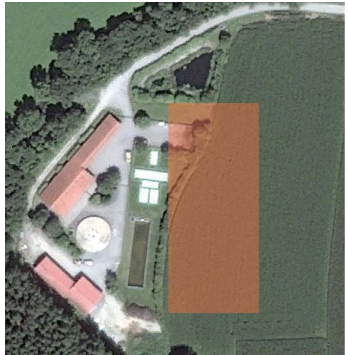
Die gemeinsame Kläranlage von Rechtmehring und Albaching: Im roten Bereich soll die Kläranlage erweitert und modernisiert werden. Bild: Google Earth
