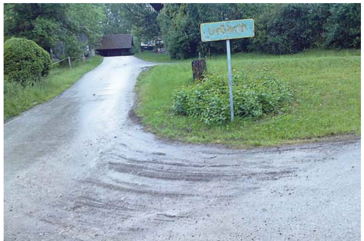
Baum weg, Busch weg, und ein neues Ortstaferl ist auch versprochen: Ein Drittel des Kreisverkehrs ist bereits fertig.
