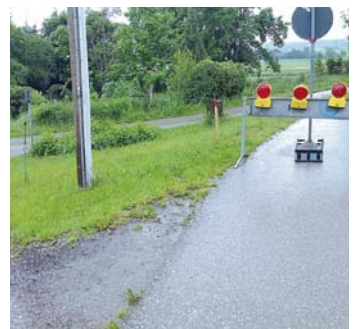
Straßensperren und erste Bauarbeiten am Teer: Gröben bekommt mehr Verkehrssicherheit. Fotos: Wimmer
