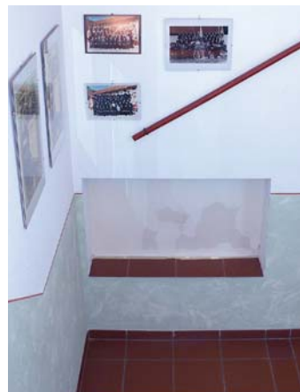
Ein Meisterwerk der Handwerkskunst: Die neuen verbarrikadierten Fenster im Feuerwehrhaus. Foto: Müller
