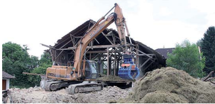
Die alte Hofstelle der Familie Gugg in Zell wurde abgerissen. Doch nicht auf diesem Grund, sondern gegenüber auf der Wiese, soll das neue Gebäude errichtet werden. Foto: Barth
