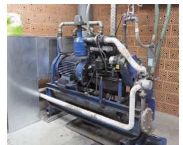
50 KW elektrische Leistung liefert der Motor in Vogtareuth. Und das aus den Vergärungsgasen von Rindergülle.
