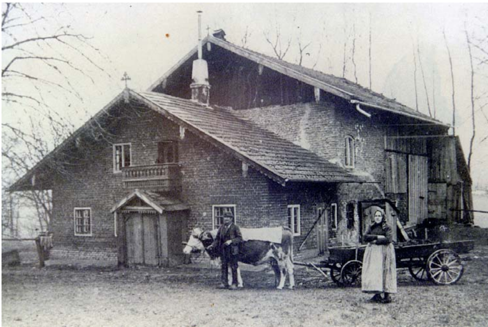
Das Bild zeigt den alten Hof beim Kainz in Hatzmoos. Er ist bereits abgerissen.
