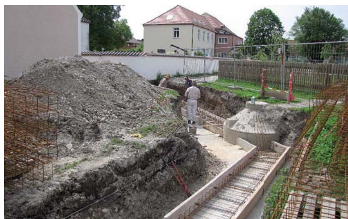
Die Fundamente sind gelegt: Ein Foto aus der Bauzeit bei der Friedhofserweiterung nördlich der Pfarrkirche. Foto: Sanftl
