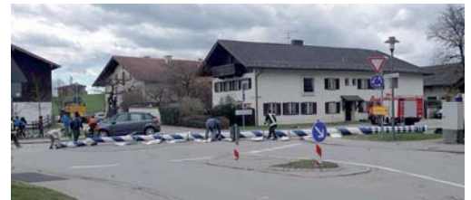
Wegen eines Sturms im März 2015 musste Der Maibaum umgelegt werden. Dabei wurde auch das Fundament stark beschädigt.
