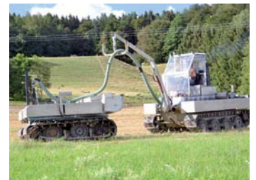
Bei der Entschlammung war schweres Gerät im Einsatz.
