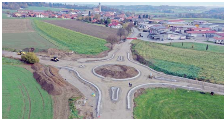
Zügig voran gingen die Bauarbeiten am Rechtmehringer Kreisverkehr. Die Bauarbeiten könnten im November noch abgeschlossen werden. Foto: Georg Barth
