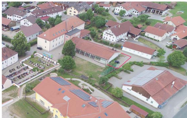
Die Hackschnitzelheizung ist im nördlichen Bereich der Alpicha-Halle in einem Kellerraum geplant (rot). Foto: G. Barth
