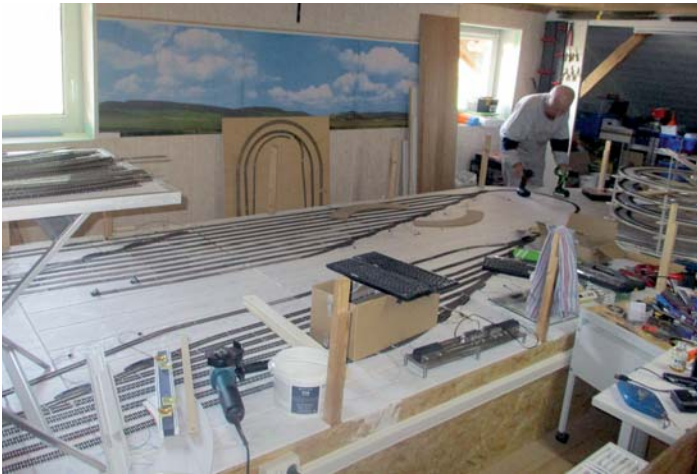
Alfred Göbl und seine Bahnhof-Baustelle.
