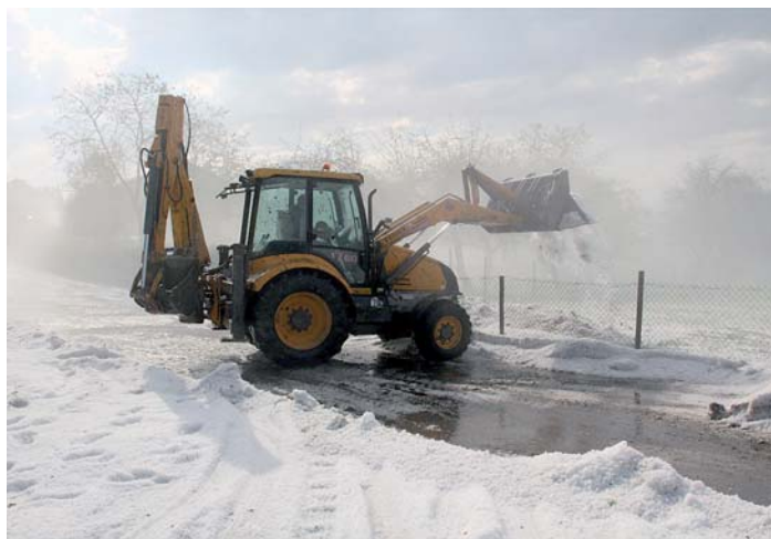
Benno Moser bei Aufräumarbeiten: Wie im tiefsten Winter.
