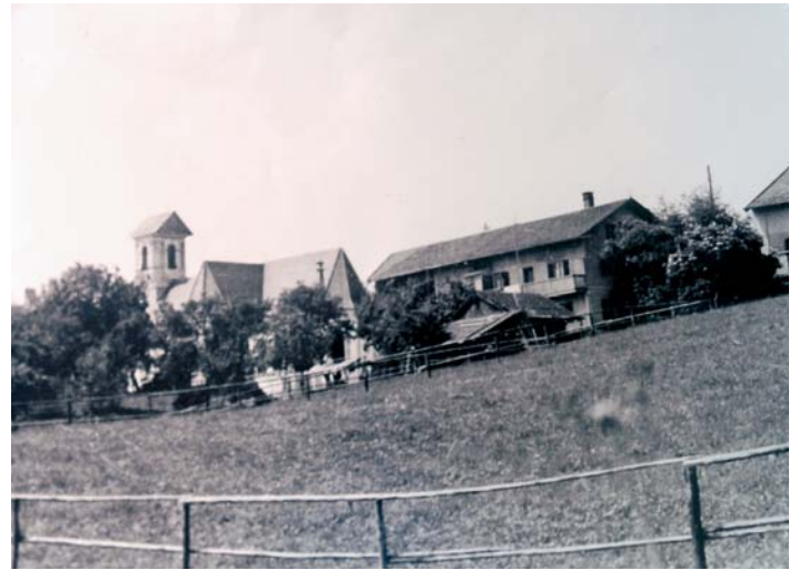
Eine provisorische Konstruktion wurde nach dem Brand auf dem Kirchturm errichtet. Quelle: L. Richterstetter
