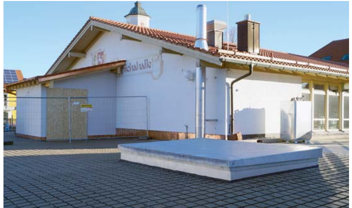
Die neue Hackschnitzelanlage wurde unterirdisch aufgebaut. Auf dem Bild das Wartungshäuschen an der Alpichhalle und der Befüllungsschacht im Vordergrund.
