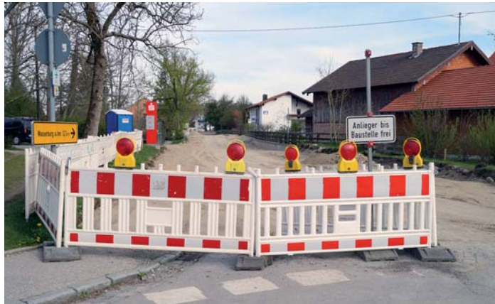
Die Hohenlindenerstraße im vollen Umbau. Es lässt nur Raum für Fantasie, was einmal aus diesem Sperrgebiet wird.
