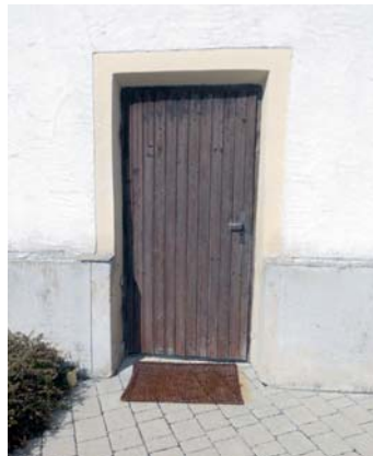
Die unscheinbare und ominöse Türe an der Südseite der Kirche. Fotos: (hm)
