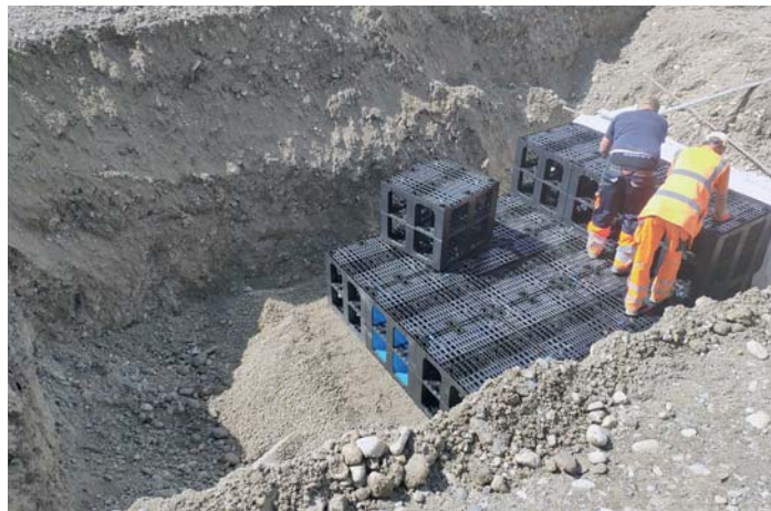
Hunderte von Bierkästen verschwinden unter der Straße. Eine moderne und energiesparende Methode im Test. Foto: gg
