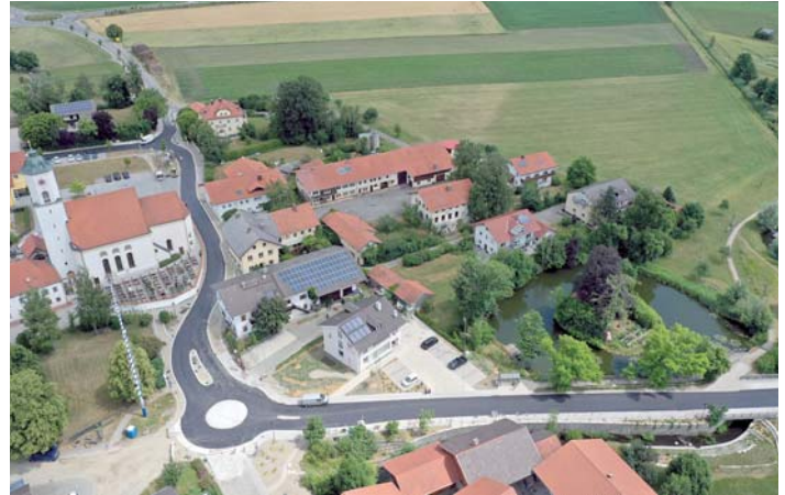
Endlich: Die neu asphaltierte Straße.
