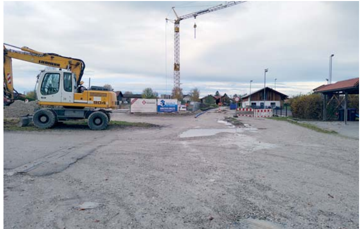
Überall Kies und viele Baumaschinen prägen derzeit das Bild am Sportgelände. Fotos: gm
