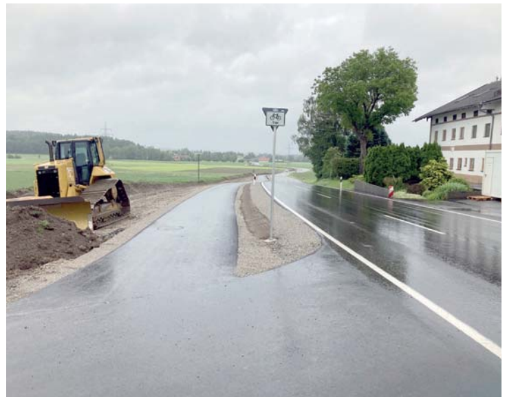
Die Sicht von Berg aus in Richtung Furth mit dem neuen Radweg entlang der Straße.
