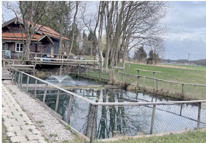
Der „Golf von Gröben“ soll vergrößert werden und bei Dürrephasen die Wasserversorgung sicherstellen. Foto: Konrad
