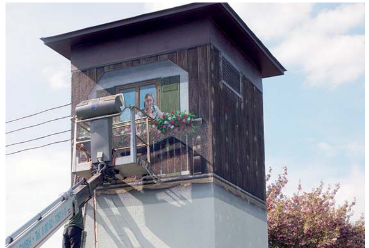
Das Bild stammt vom 14. Mai 2013 - 12 Jahre später wurde das Trafohäuschen dem Erdboden gleich gemacht. Foto: gg
