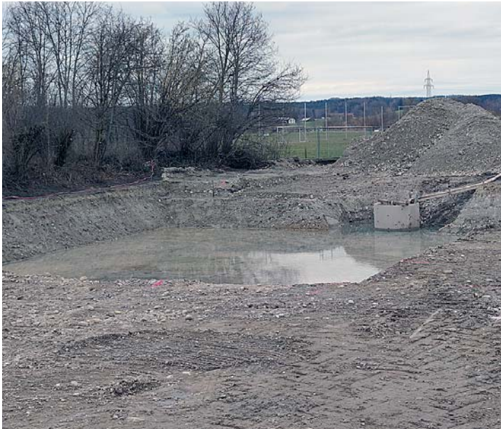
Die Baugrube ist ausgehoben, der hohe Grundwasserspiegel ist gut zu erkennen. Es wird permanent abgepumpt.
