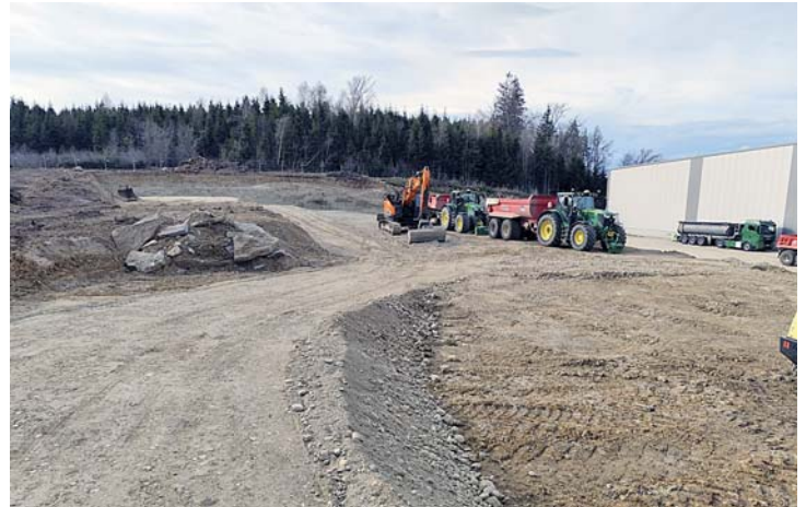
Aktuell wird im Gewerbegebiet viel gegraben: Der Aushub für die neue Kühlhalle bei der Firma Huber. Foto: gg
