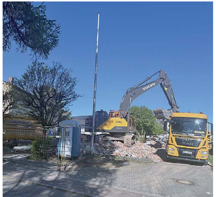
Die Bagger sind angerückt und haben das alte Gebäude abgerissen. Ein Stück Maitenbether Geschichte ist verschwunden. Foto: ri
