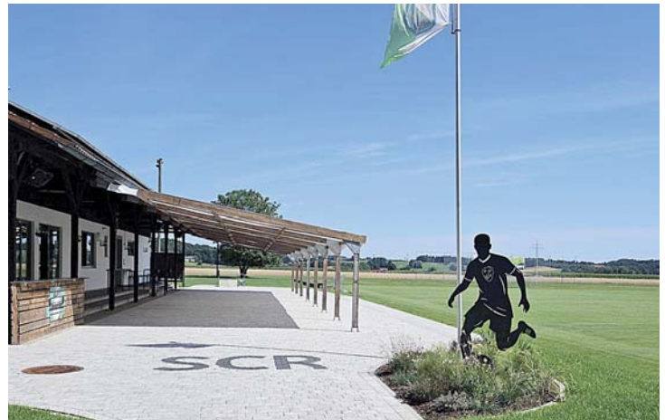
Der neue Eingangsbereich des SCR wurde von Heinz Achatz und seinem Agala-Team gestaltet. Weitere Firmen und Helfer beteiligten sich bei den Arbeiten an der gesamten Anlage.
